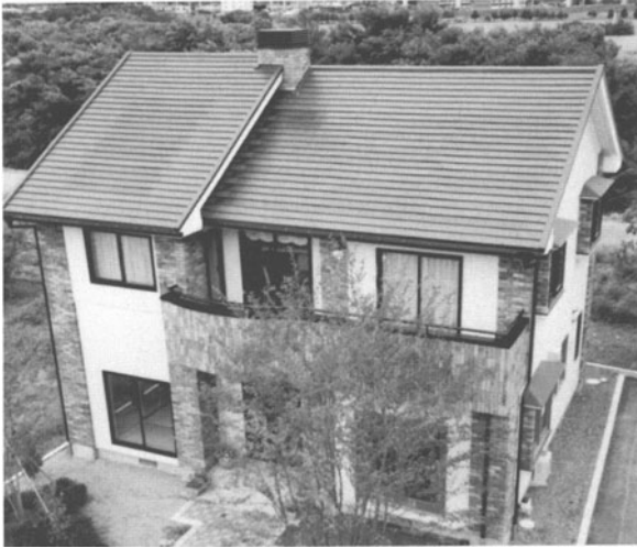
Fig. 12.19. Example of BIPV modules (a-Si)
